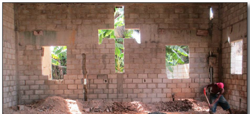
Noviembre 2013: La pared posterior del primer piso.
