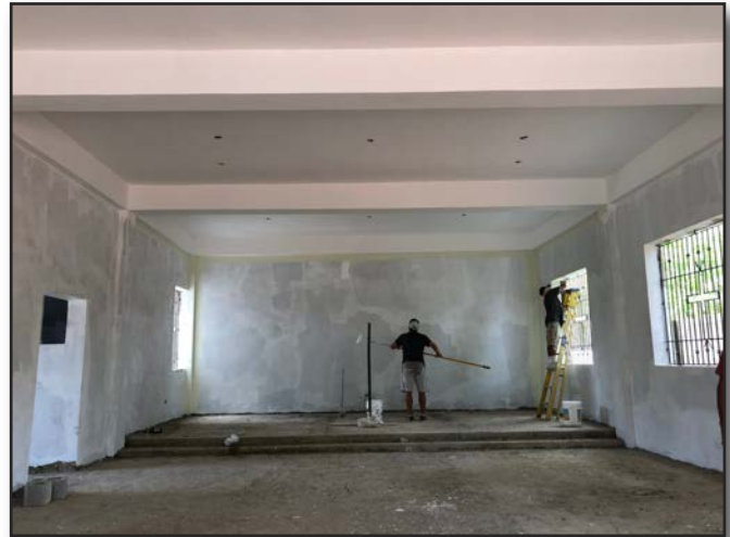
Working inside the building. Trabajando dentro del edificio.
