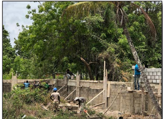
Working on the perimeter wall. Trabajando en el muro perimetral.
