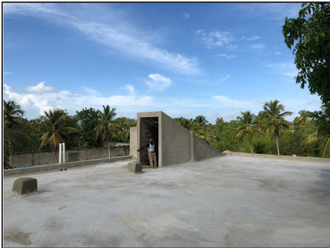
The access door for the roof of the building. La puerta de acceso para el techo del edificio.
