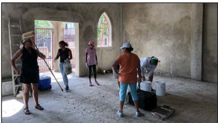
Preparing to paint the inside of the building. Preparación para pintar el interior del edificio.
